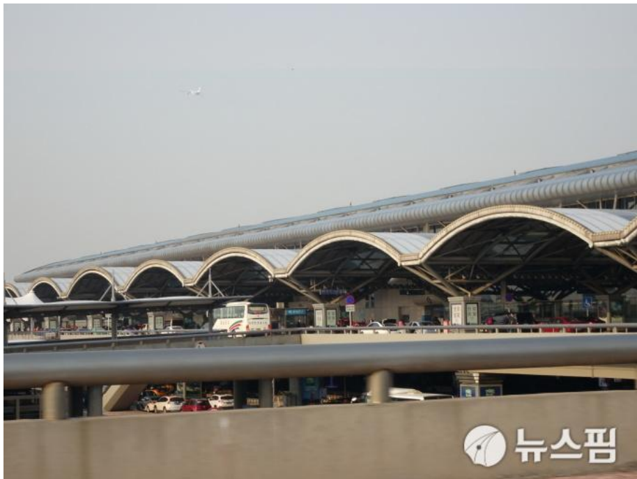
베이징 서우두공항 전경 [사진=백진규 기자]
